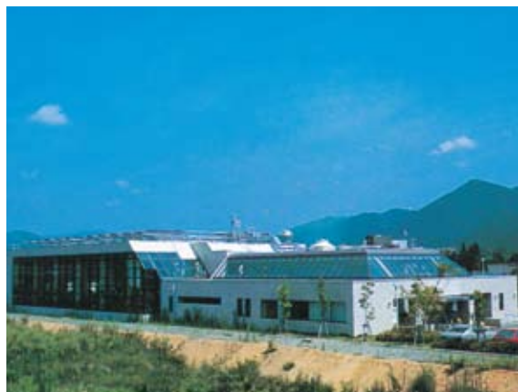
福知山市室内温室プール
