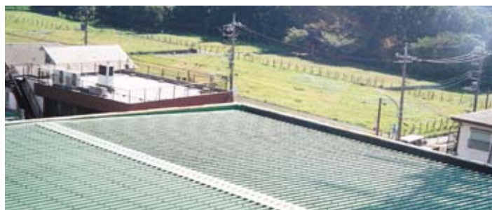
東京都町田市立 第2中学校体育館
