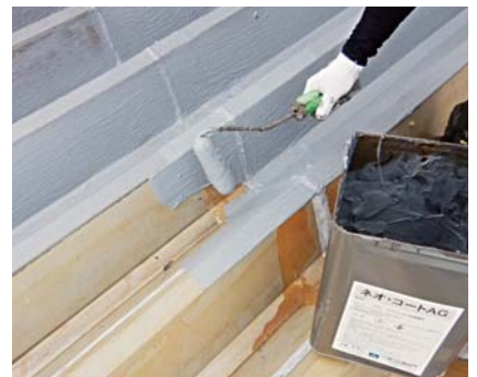
ネオ・コートAG塗布状況
