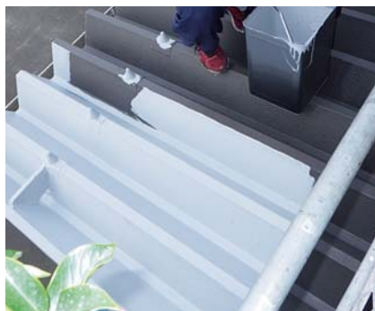
AGトップコート塗布状況
