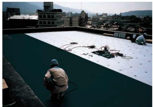
(シートの張付け)
