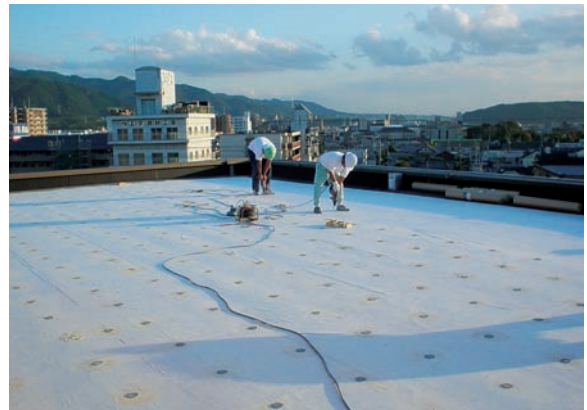
(固定金具の取付け)
