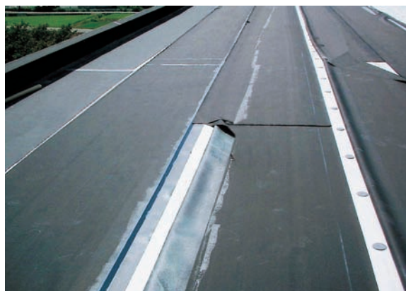
（シートの接合部の張付け）
