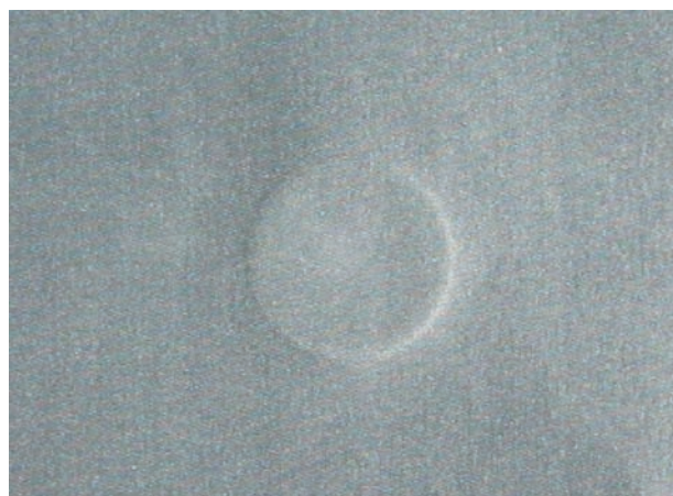
融着状況(シート外観)
