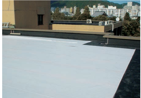
(絶縁シートの敷設)
