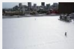
屋上防水 施工例
