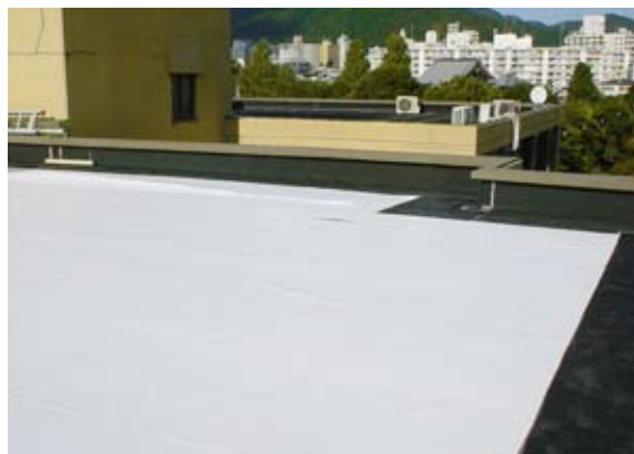
(絶縁シートの敷設)
