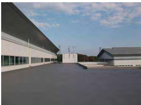
耐久性に優れたゴムシートを使用し、耐熱性に優れたポリスチレンフォームと高反射塗料で**夏の暑さや冬の寒さから空調費を低減**します。また、スターフォーム防水工法は、**無溶剤系接着剤を用いた被せ工法**により、騒音や振動がなく、**廃棄物の発生を低減させる環境に優しい防水工法**です。
