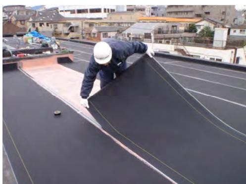
セパレータフィルムを使用しない片面接着工法用の接着剤付加硫ゴム系防水シート「**ネオ・ルーフィングE (糊付)**」を開発しました。従来の接着剤付シートに比べ、**施工能率が向上し、併せて廃材を大きく削減できる環境対応型**の防水シートです。
