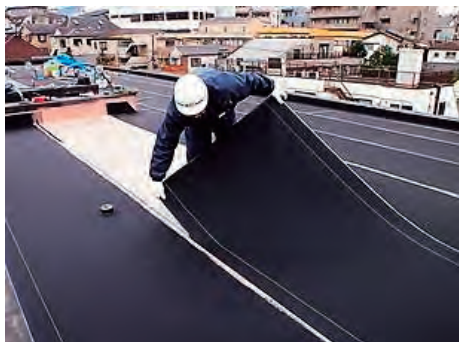
施工現場の風景
