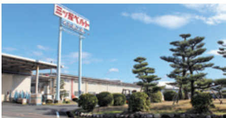
建設資材を製造している名古屋工場
