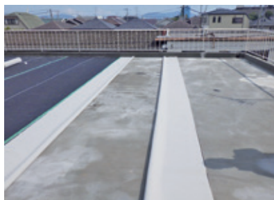
シート敷設工程
