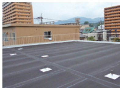
敷設後・塗装前
