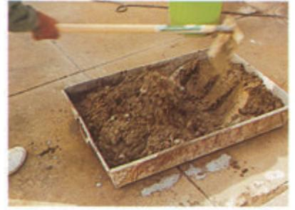
②フラットタイト®P1缶(18kg)に水8ℓを加え練り上げる。固さは水の量で調節する。
