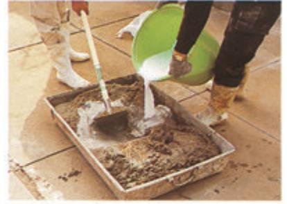
③モルタル接着補強用の混合液(フラットタイト®P1:水2の割合)を下地のモルタル面に塗布してから、先に調合したモルタルを打設する。
