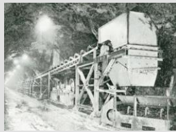
黒四ダムの大町トンネル内に設置された 三ツ星コンベヤベルト
