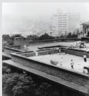
首相官邸の屋根防水を施工(1963年)
