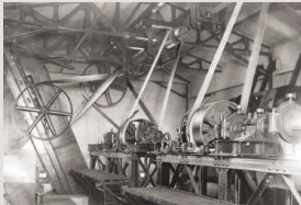
平ベルト使用の洗炭機 (石炭を洗って不純物を除く工程の機械)
