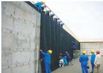
④ 電磁誘導加熱機による溶着
