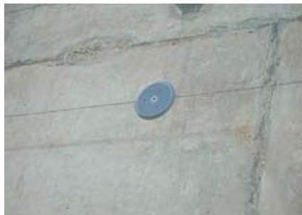
④ 電磁誘導加熱機による溶着
