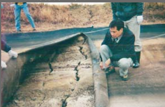
■ シート切開後下地確認
