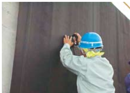
④ 電磁誘導加熱機による溶着
