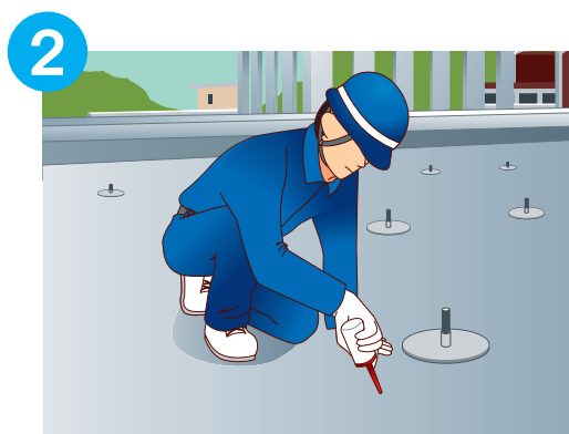
切粉除去・エポキシ注入
