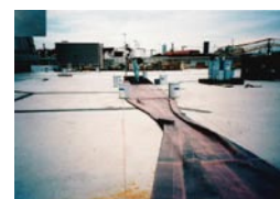
接着剤を塗布する際に風によりシートが煽られた現場
