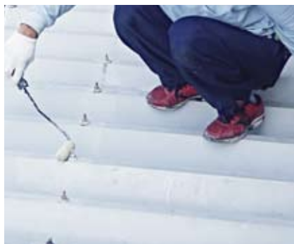
メタルプライマーF塗布状況
