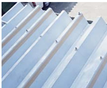
カシメ部両面テープ(5640)張り付け状況
