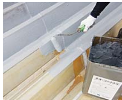
ネオ・コートAG塗布状況
