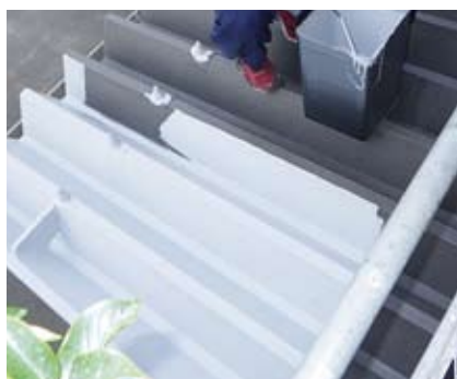
AGトップコート塗布状況
