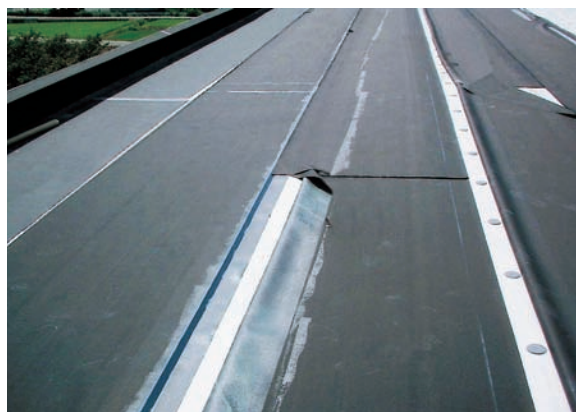
（シートの接合部の張付け）
