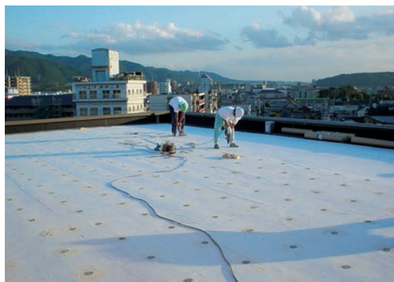
(固定金具の取付け)
