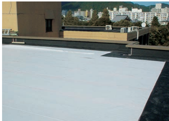
(絶縁シートの敷設)
