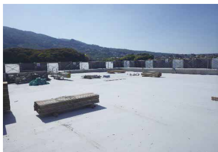
コンクリート下地
