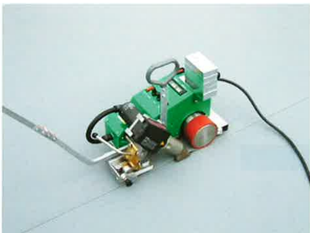
自走式溶接機によるシート接合
