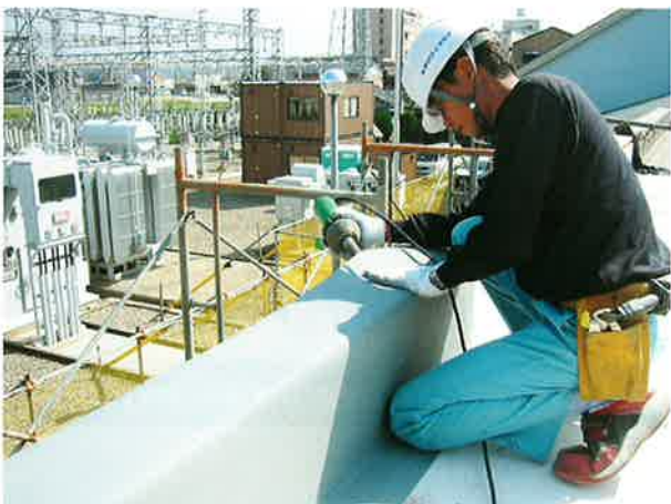
手動式溶接機によるHJアングルへの熱融着固定
