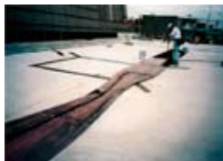
接着剤を塗布する際に風によりシートが煽られた現場
